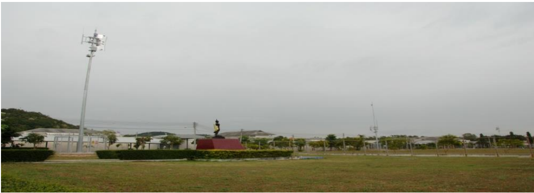
การติดตั้งเครื่องตัดสัญญาณโทรศัพท์มือถือในเรือนจำความมั่นคงสูง
